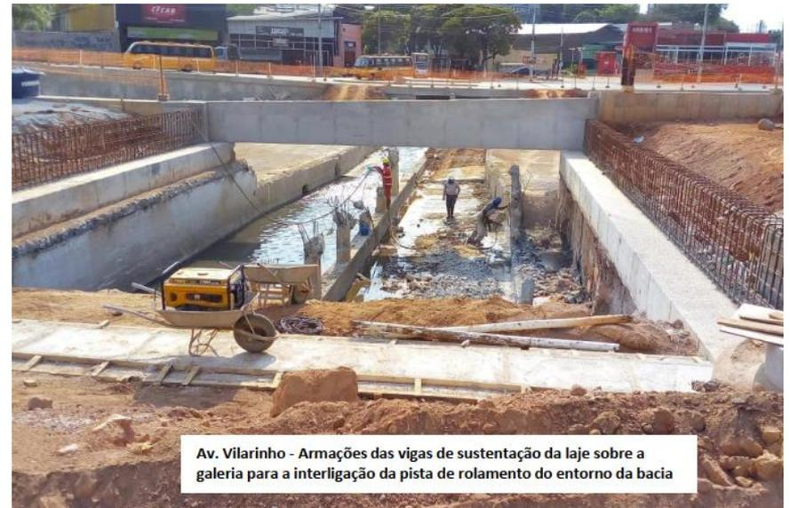
Av. Vilarinho - Armações das vigas de sustentação da laje sobre a galeria para a interligação da pista de rolamento do entorno da bacia
