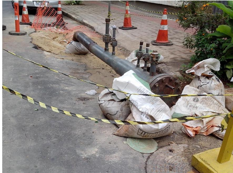
Equipamento para injeção de nitrogênio em alta pressão para testes de verificação de possíveis vazamentos em pontos de solda da tubulação de aço carbono
